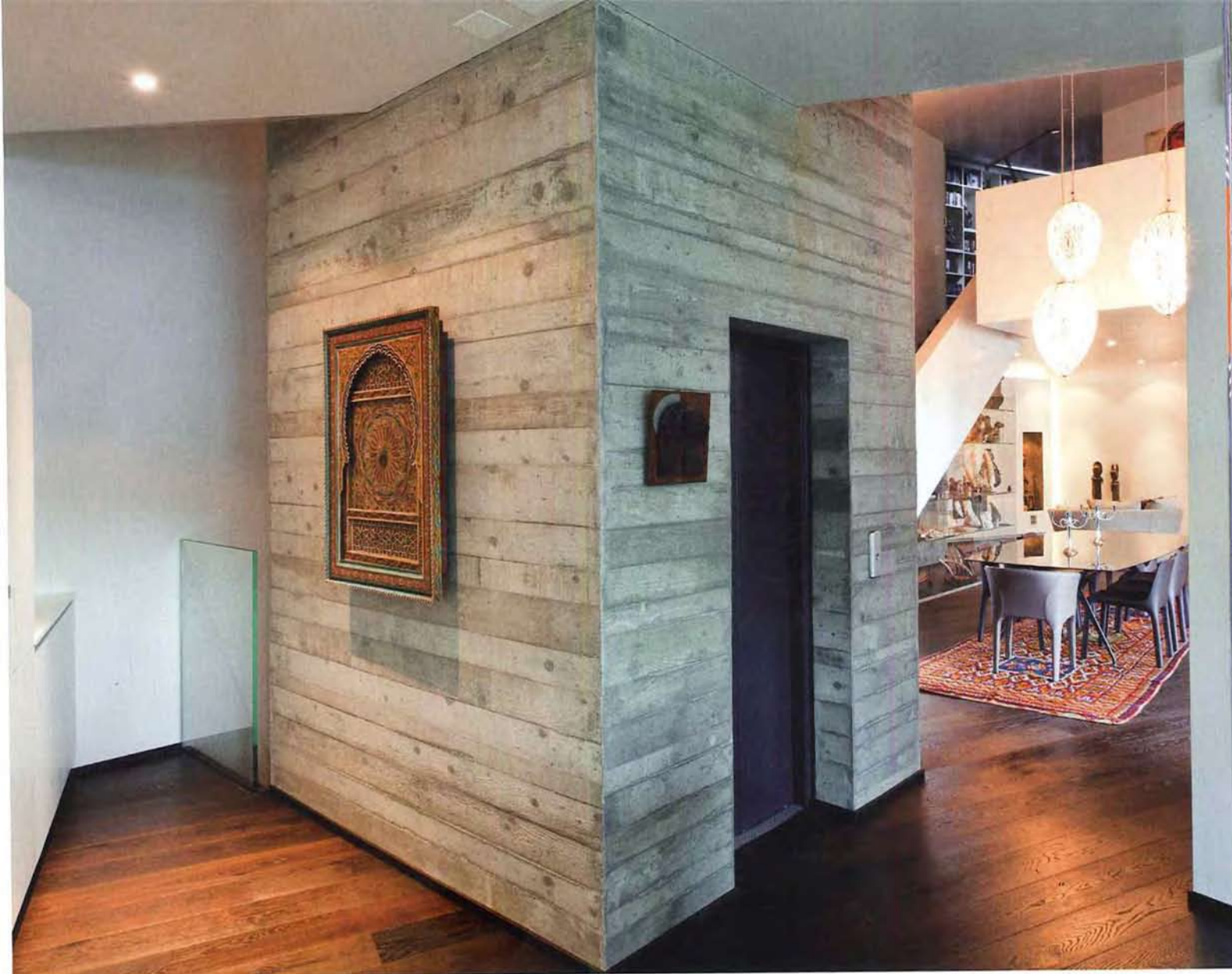
Il blocco dell'ascensore in cemento armato ripete all'interno la particolare finitura del cassero in legno grezzo che si ritrova sui muri esterni.
