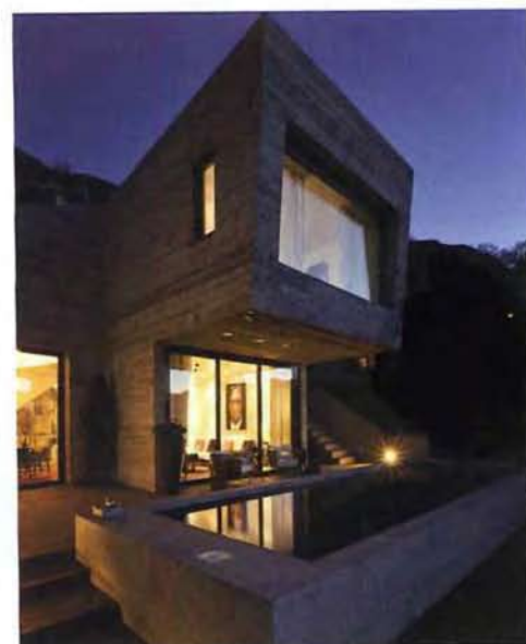
Sulla piscina si affacciano la zona del soggiorno e sopra sporgente il volume della camera padronale.
